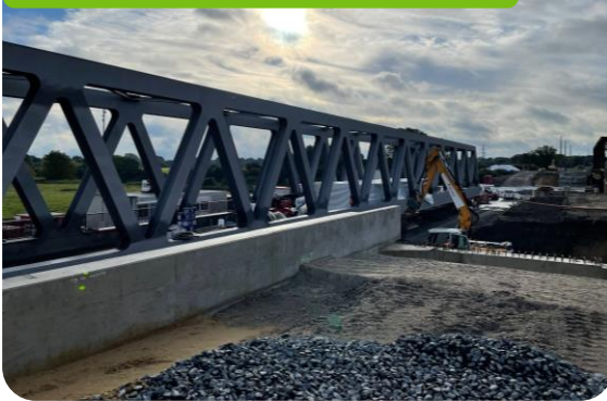
Blick auf das Bauwerk
