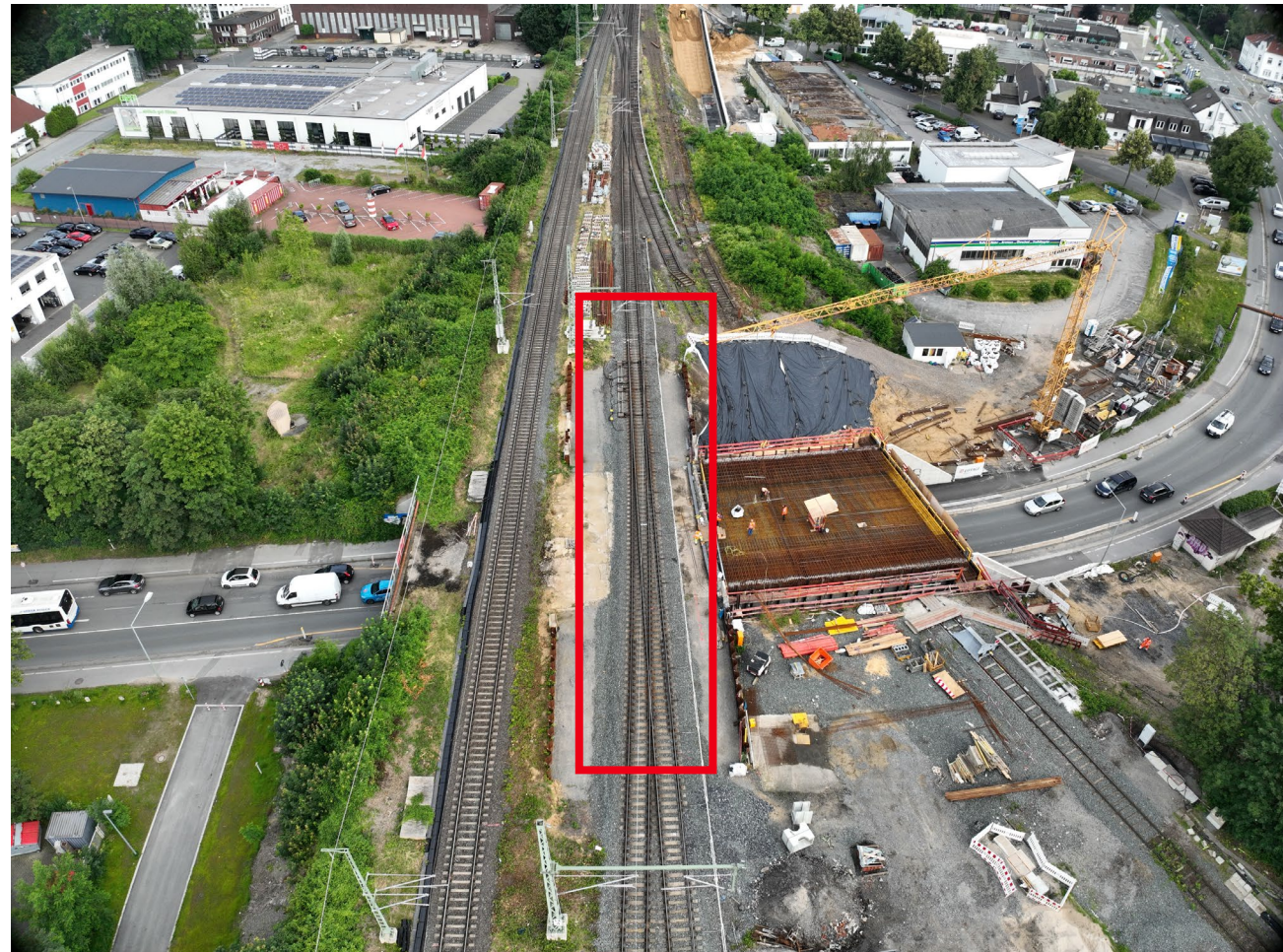
Herstellung neues Brückenbauwerk
