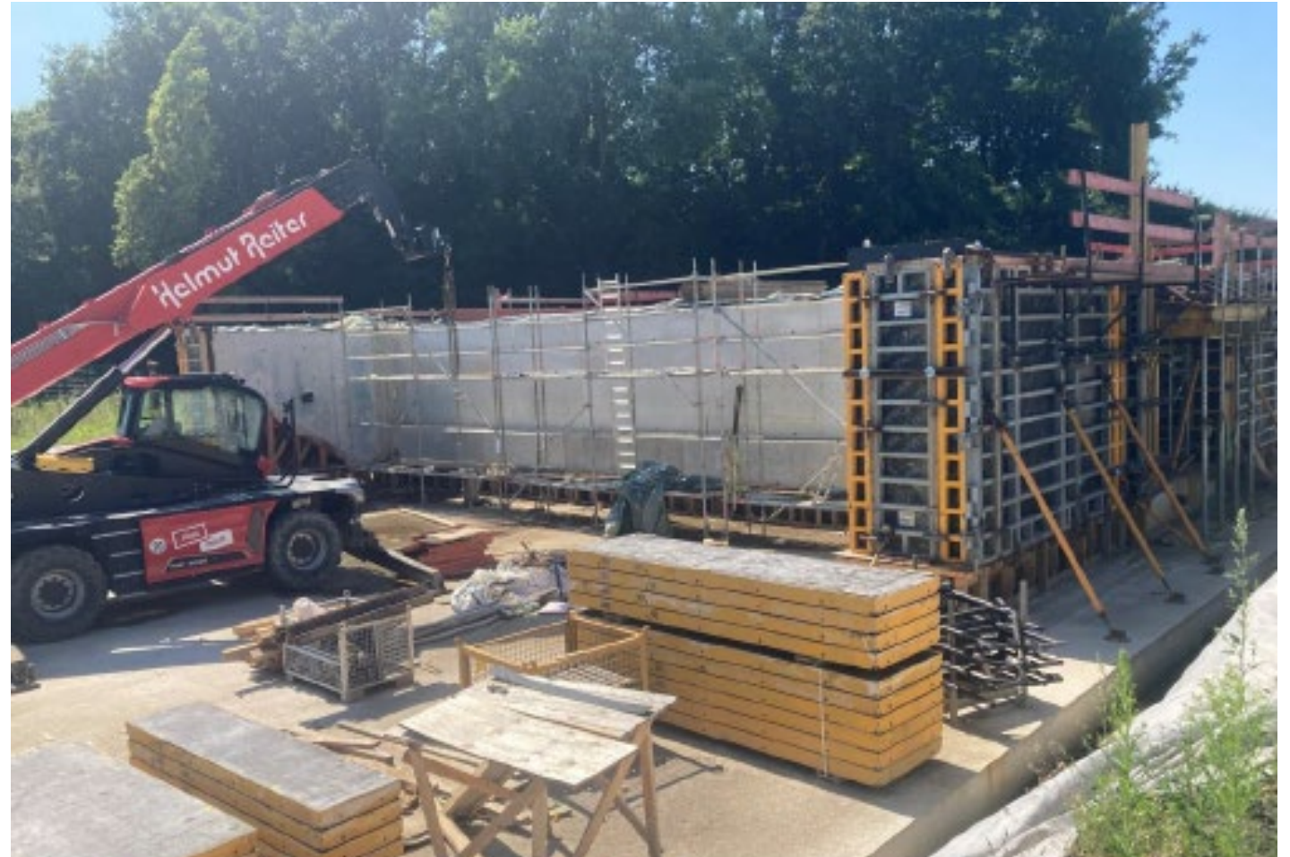
Bauwerk an der EÜ Landwehrstraße/Küpperstraße
