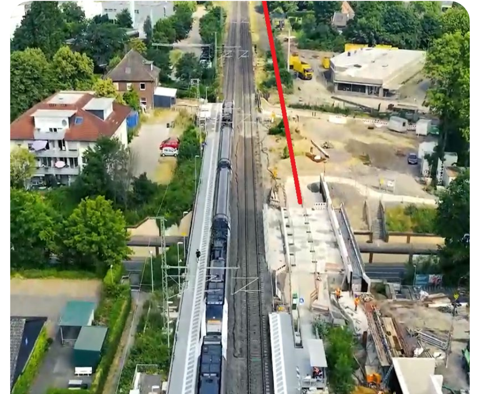
Errichtung des Erschütterungstrogs zwischen Hedwigstraße und Ökotunnel
