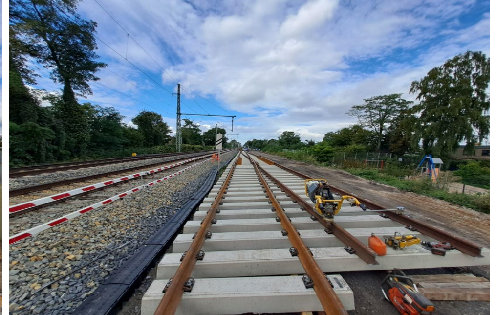
Aktueller Stand vom „neuen Gleis 4“ und der Weichenmontage
