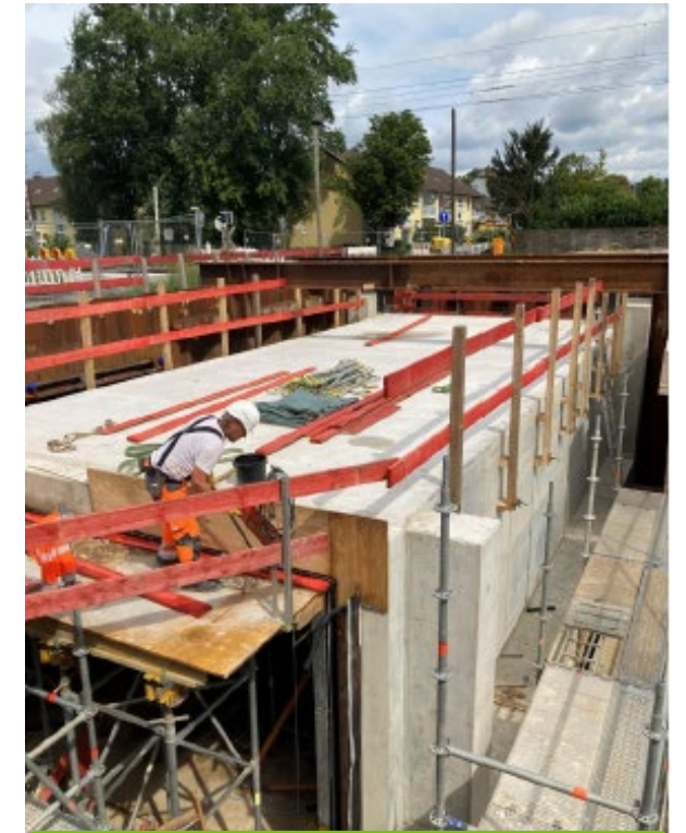
Blick in die Baugrube
