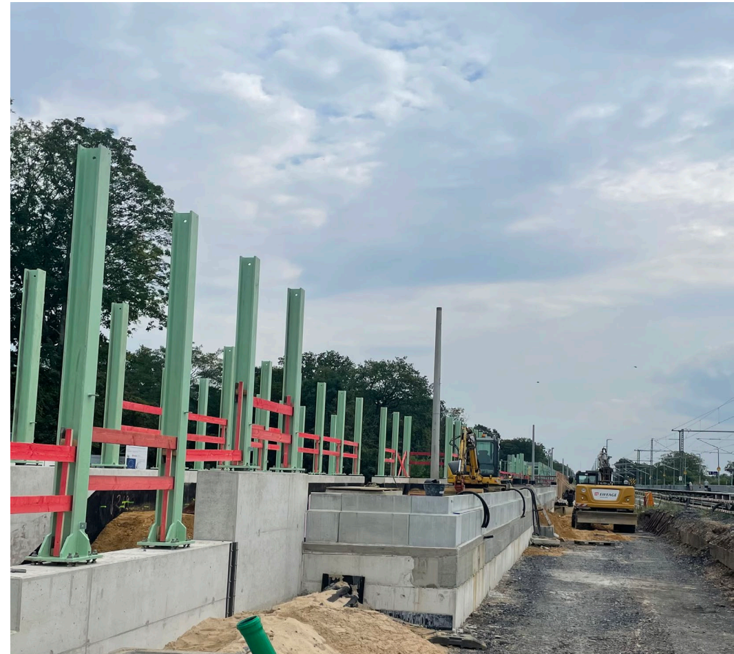
Schallschutzwandpfosten neben der Bahnhofstraße im Bereich des Haltepunkt Voerde
