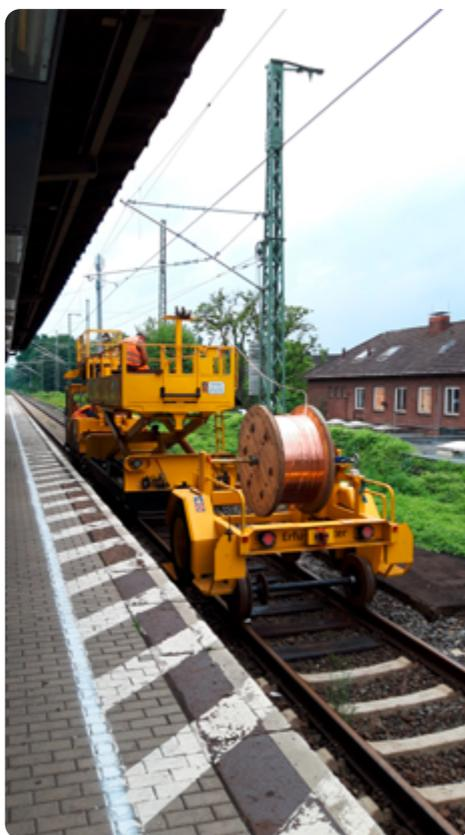
Montage des neuen Kettenwerks an der Oberleitung im Bf. Dinslaken
