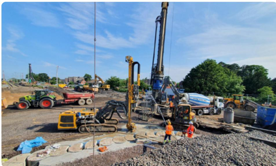
Herstellung von Bohrschablonen für die Bohrpfähle des zukünftigen Rahmenbauwerks an der EÜ Bahnhofstraße
