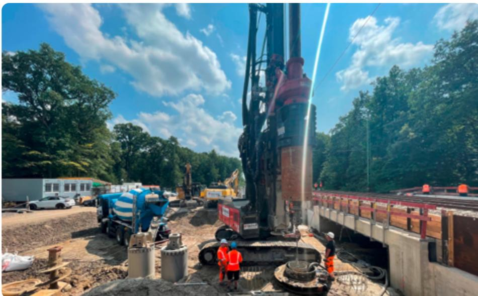
Bohrpfahlarbeiten im Bereich der EÜ Lohberger Entwässerungsgraben
