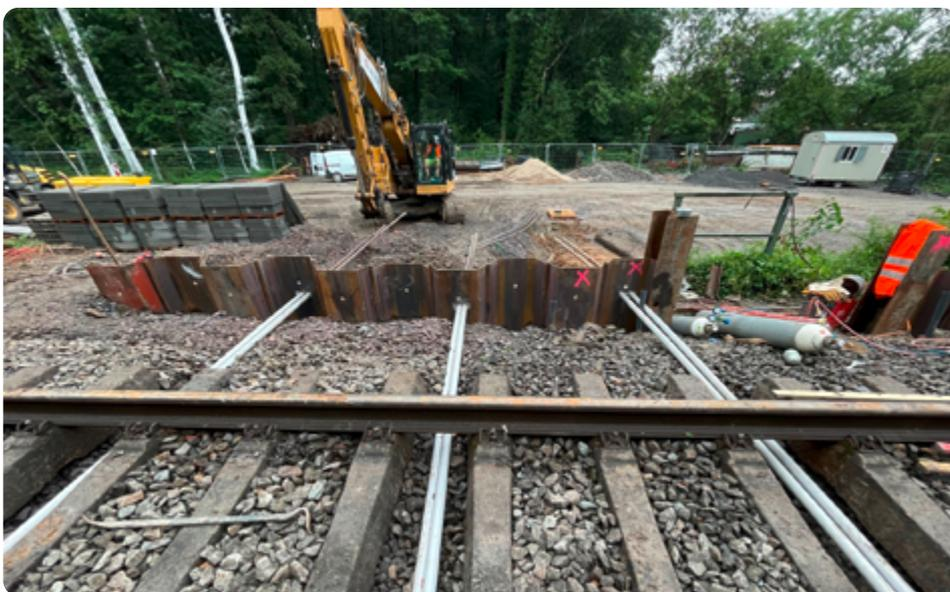
Gleislangverbau mit Totmannanker als Rückverankerung im Bereich der EÜ Ökotunnel
