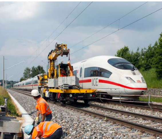
Die Blockverdichtung wird im Rahmen des dreigleisigen Ausbaus realisiert.
